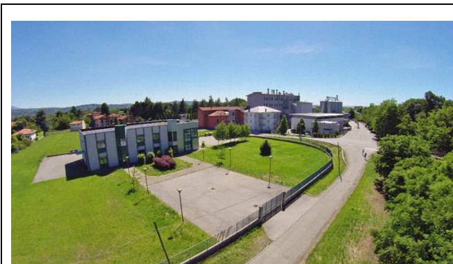
Fabbricato "ex Centro mele" esistente
