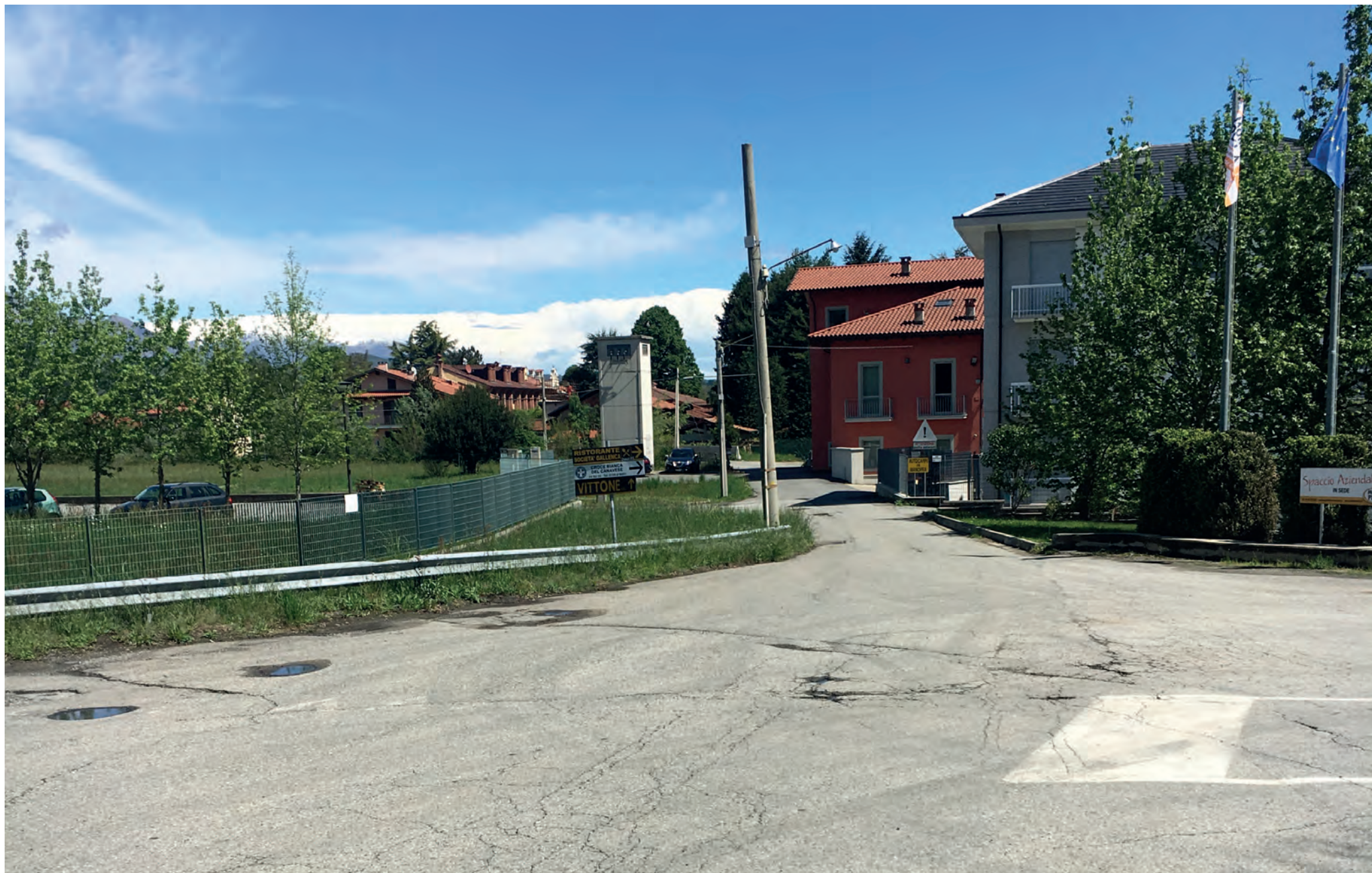
Vista da Strada Comunale di San Bernardo - Intervento 2 - ESISTENTE
