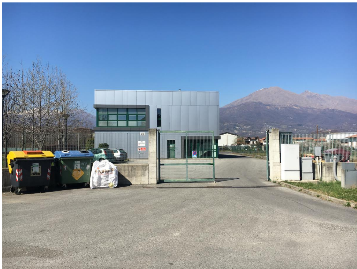
FABBRICATO EX CENTRO MELE - INGRESSO DA STRADA COMUNALE SAN BERNARDO
