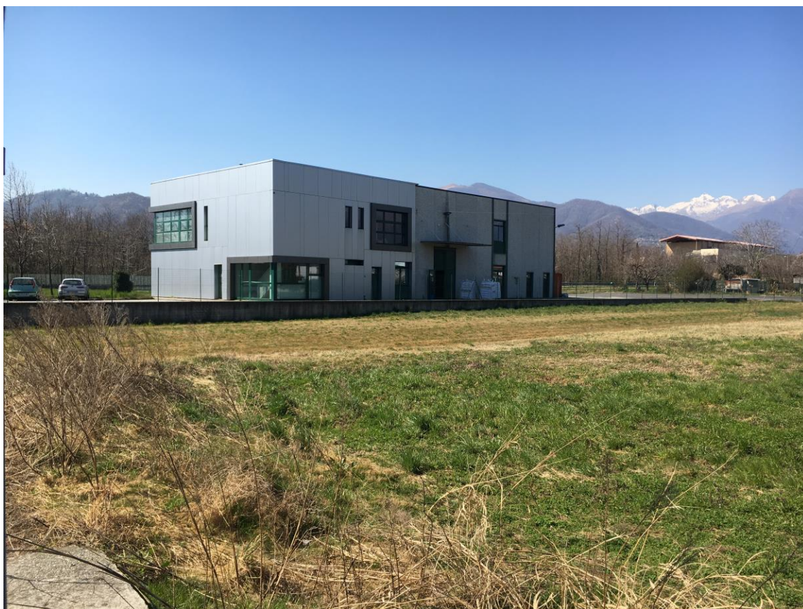
FABBRICATO EX CENTRO MELE - VISTA DA CABINA ENEL
