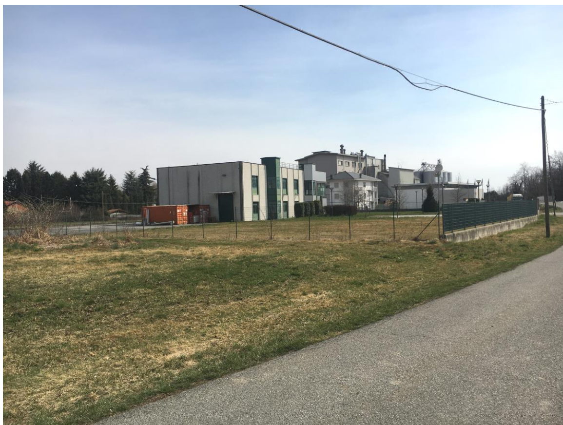
FABBRICATO EX CENTRO MELE - VISTA DA STRADA VICINALE DI GALLENCA
