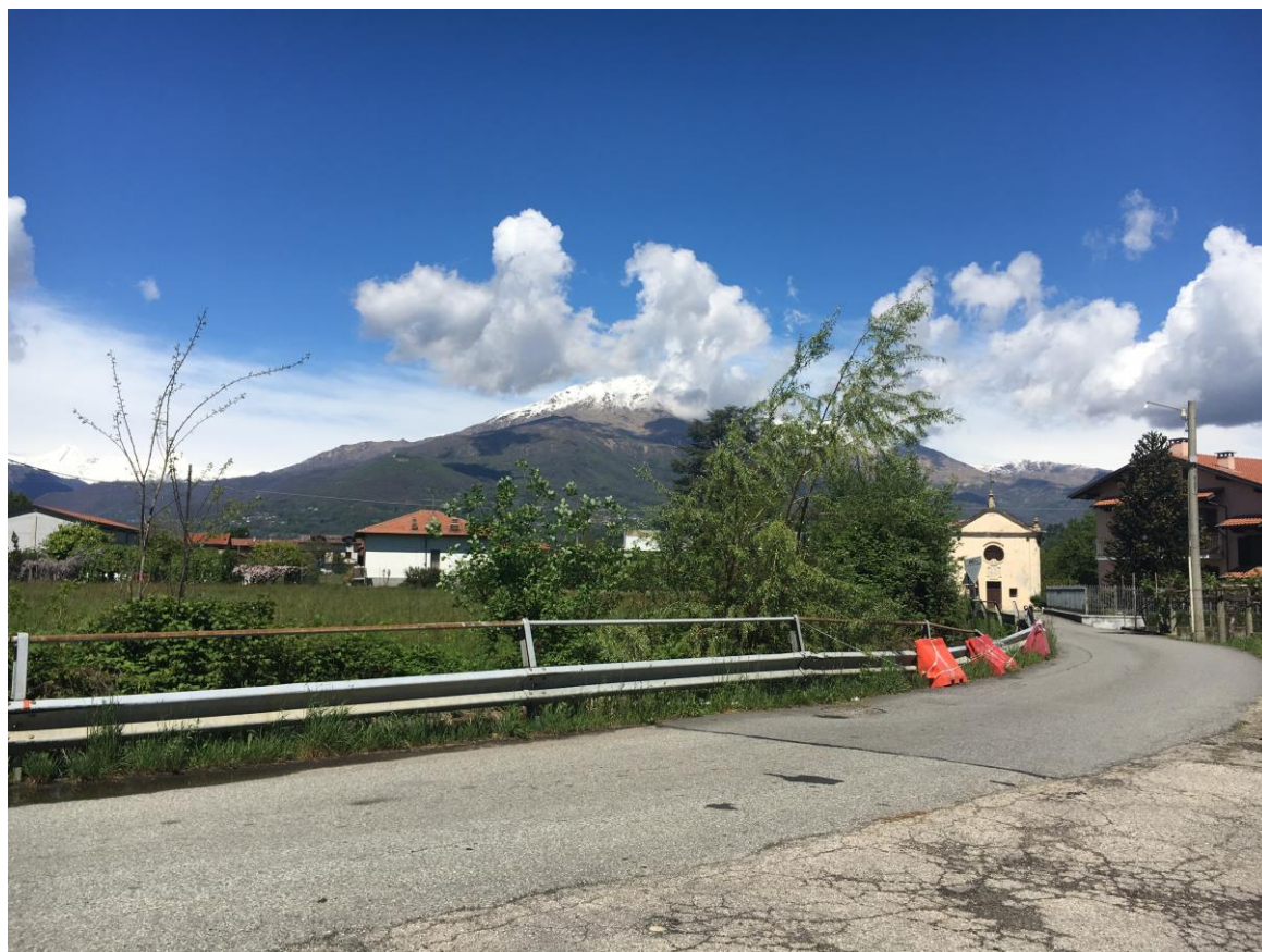
CANALE DI FAVRIA DA PARCHEGGIO AREA PE5A
