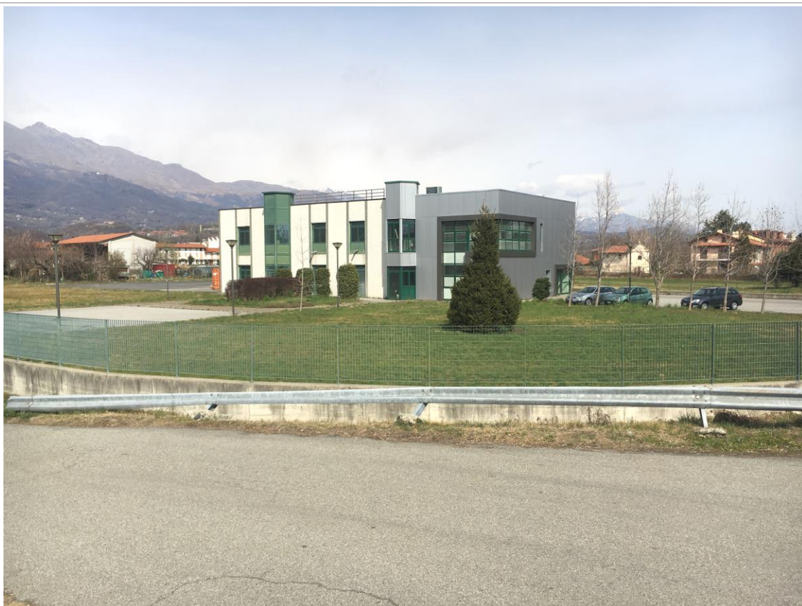
FABBRICATO EX CENTRO MELE - VISTA DA STRADA COMUNALE DI SAN BERNARDO
