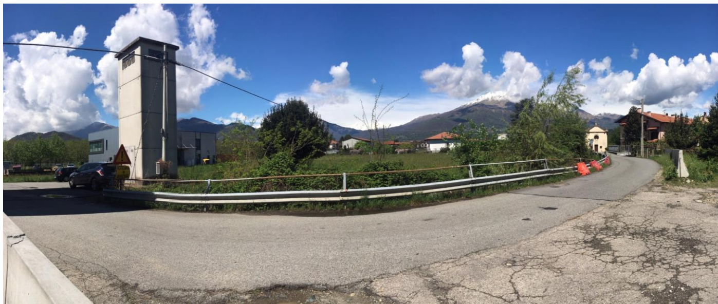
CANALE DI FAVRIA DA PARCHEGGIO AREA PE5A VISTA PANORAMICA
