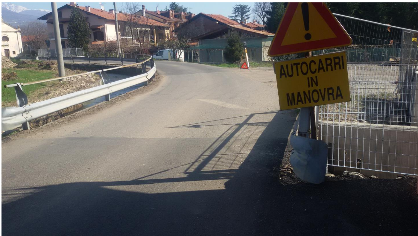
STRADA COMUNALE DI SAN BERNARDO RESTRINGIMENTO CARREGGIATA ATTRAVERSAMENTO CANALE DI FAVRIA
