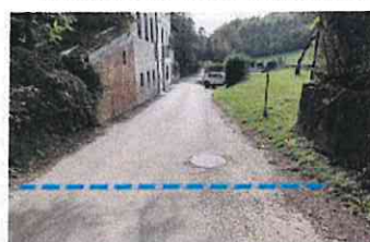
Inserimento canaletta carrabile per lo scolo delle acque su Strada Vecchia per Cuorgnè
