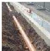
Posa tubi flessibili (PE, PVC, analoghi) e relative opere prefabbricate (pozzetti, camerette d'ispezione, simili) per fognatura. L'operatore della terna, secondo gli ordini dell'operaio in trincea, cala in trincea il tubo. L'operaio in trincea provvede a spingere il tubo fino ad innestarlo nell'altro già posato e a effettuare la saldatura a caldo del giunto.
